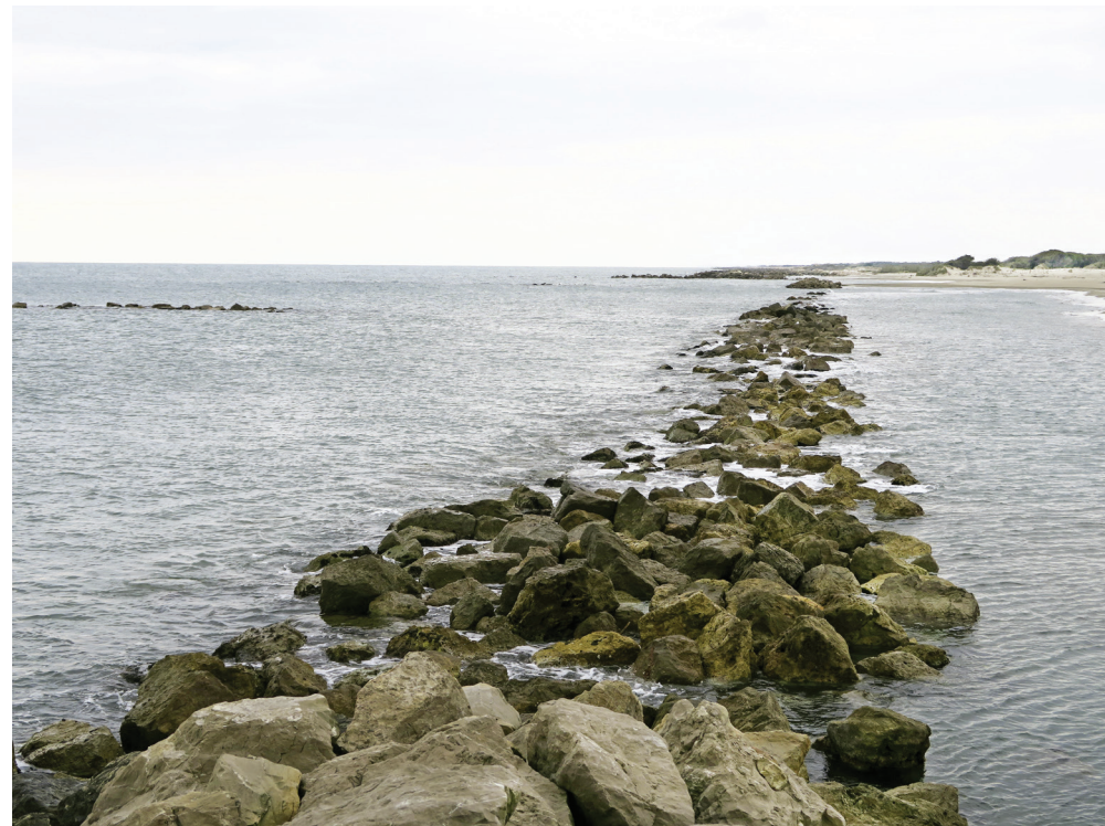
Détérioration de la digue à la mer
